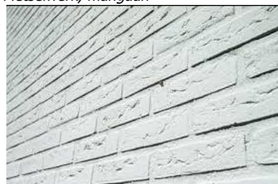
Metselwerk, "Keim"steen muurverf
